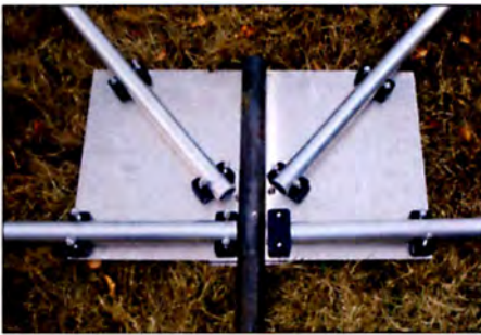
Bild 12: Zentraler Knotenpunkt der Antennenkonstruktion Fotos: DK6ED
